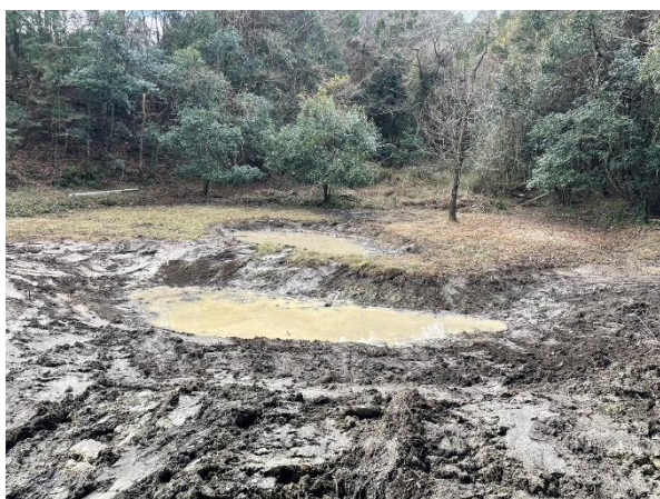
写真 2-2-3 移植地 B 整備後（湿地下部より）
