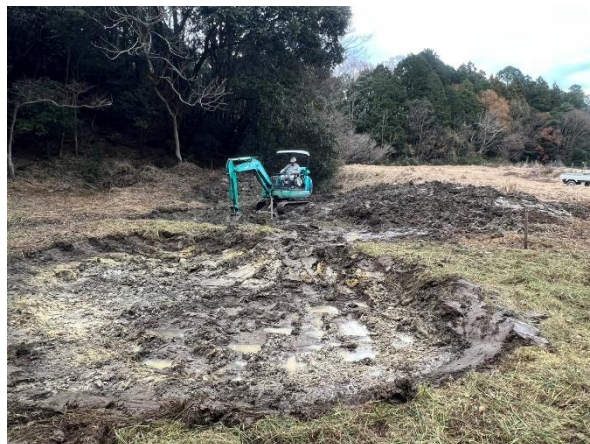
写真 2-2-2 移植地 B 整備中（土工事）
