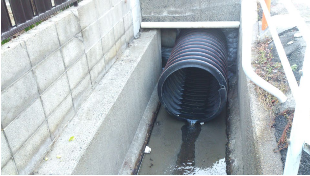
図-10 水路の仮復旧状況
