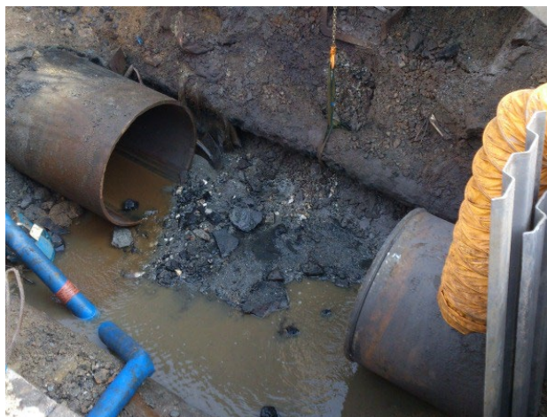
図-8 配水管の切断
