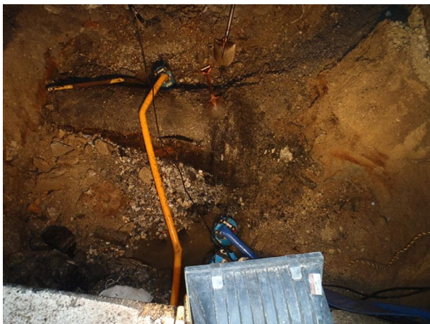
図-6 漏水箇所
