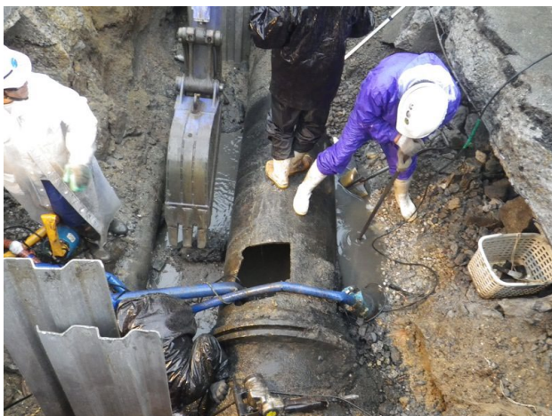
図-7 管内の配水作業
