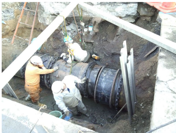
図-9 配水管の接合作業
