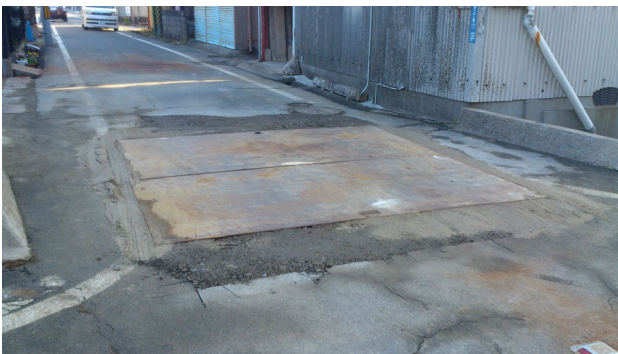
図-12 路面の仮復旧状況
