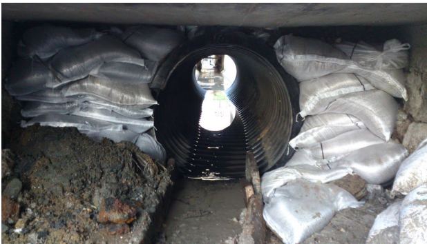
図-11 小口止めの土嚢
