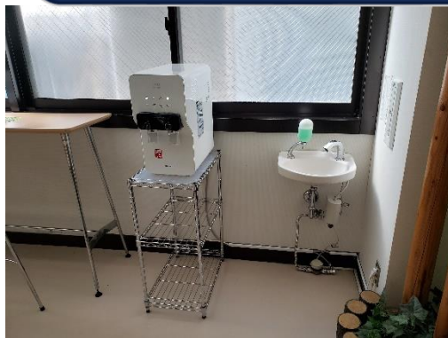
県庁厚生棟地下1階に設置
