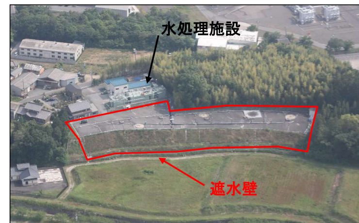
遮水壁の設置
