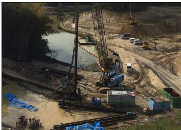
鋼矢板による浸出水の拡散防止
