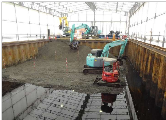
釜場掘削による油回収
