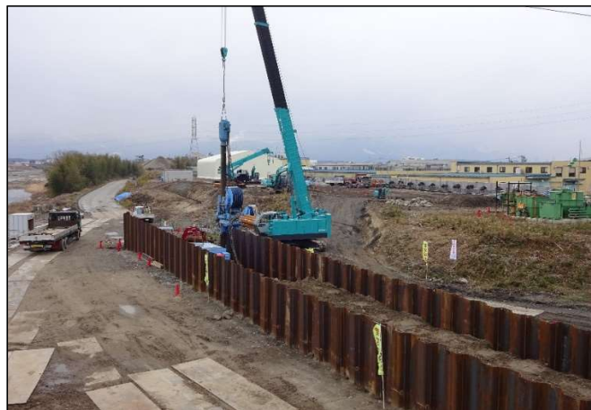
鋼矢板による囲い込み
