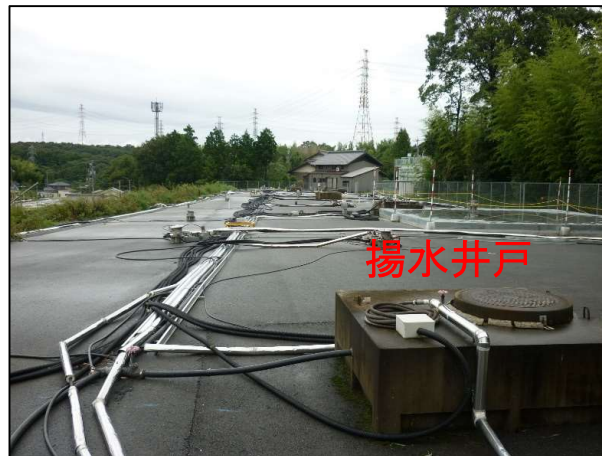
汚染地下水の揚水浄化
