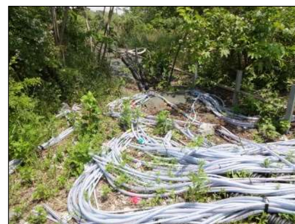
事案地内の注入配管
