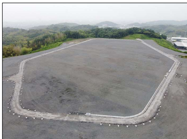
埋立区域天端の覆土
