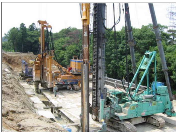
遮水壁の設置
