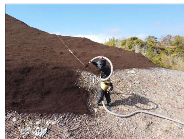
法面への厚層基材の吹付
