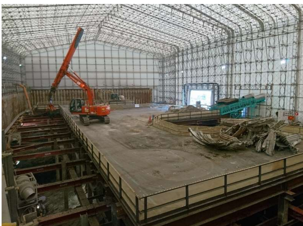
テント内での廃棄物の掘削
