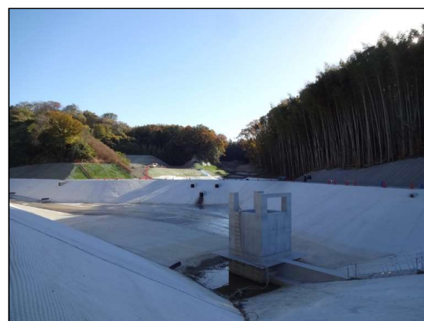
雨水調整池の設置
