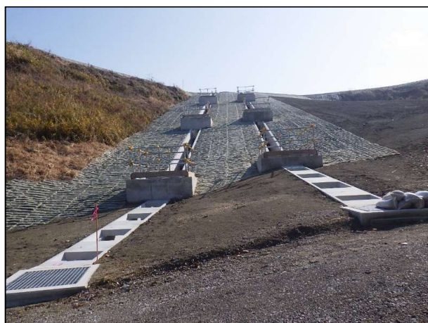
雨水排水路の整備
