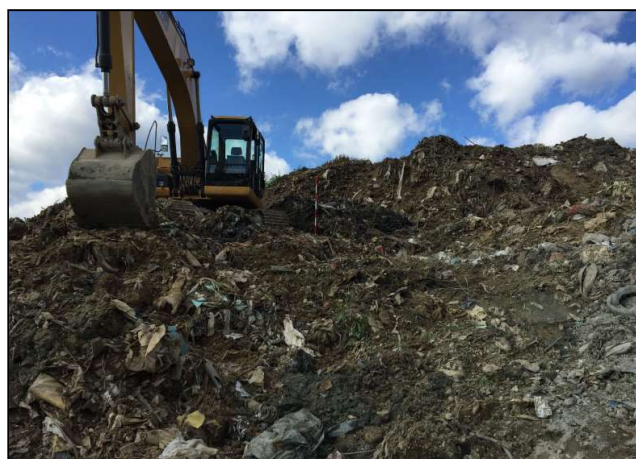
廃棄物の撤去整形
