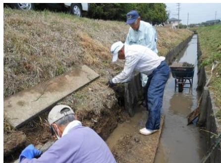
水路の補修作業
