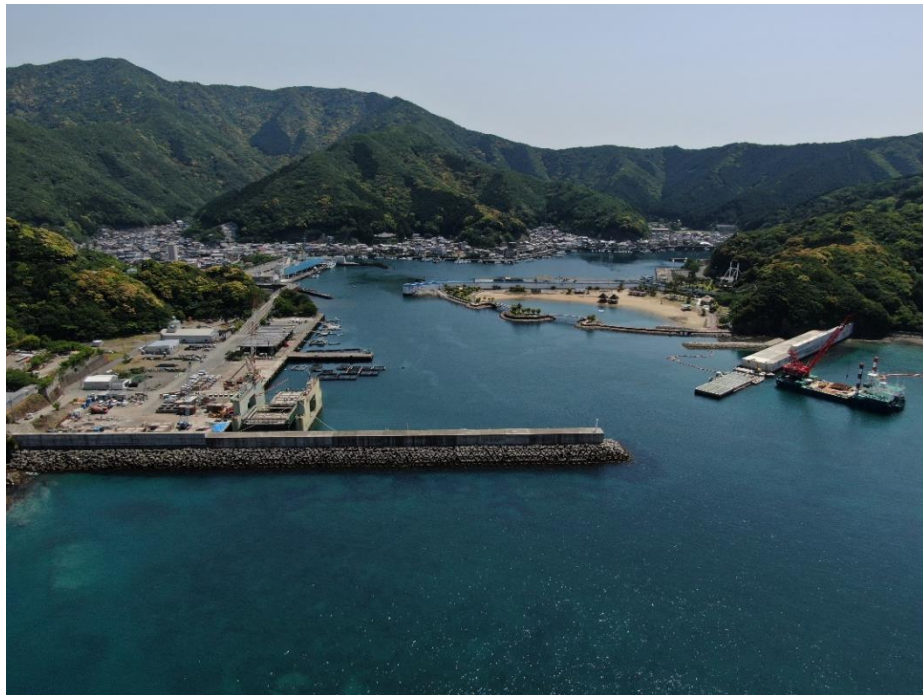
防波堤の整備
