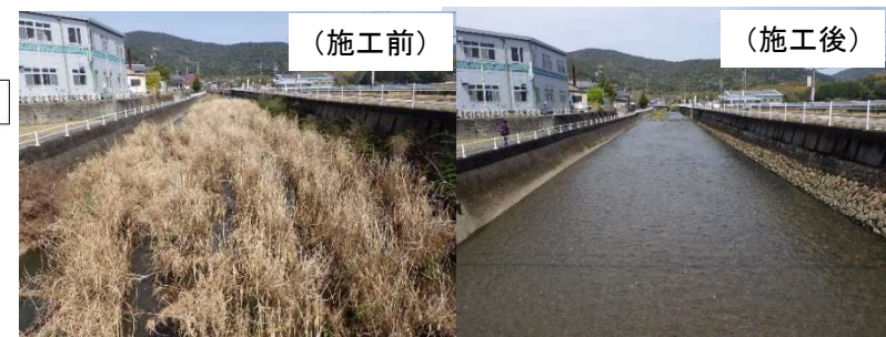
磯部川緊急浚渫推進事業 （三重県）
