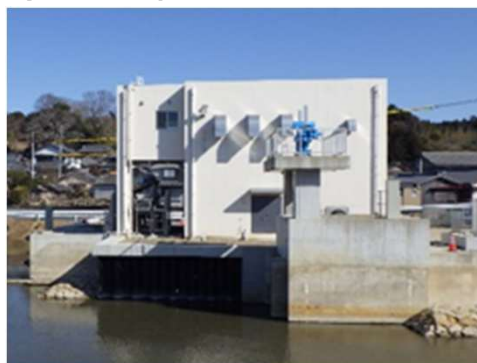
農村地域防災減災事業(令和4年度完成) (三重県:磯部川水系)
