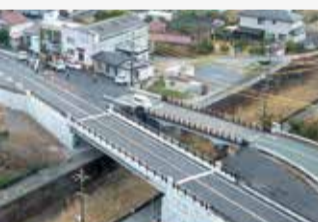
一般国道 260号 東宮橋の架け替え
