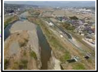
員弁川河道拡幅・桑部橋架替 （三重県）
