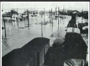
昭和34年伊勢湾台風時 浸水状況（桑名駅付近）
