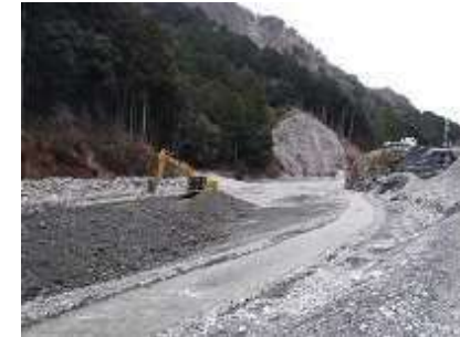
砂防堆積土砂撤去事業 (三重県)
