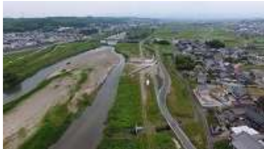
員弁川河川改修事業 (三重県)
