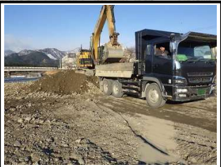
河川堆積土砂撤去（三重県）
