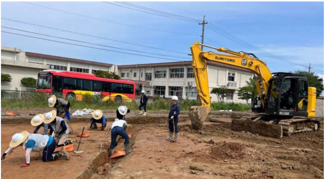
※調査地表土掘削の様子
