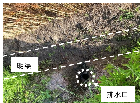
明渠と排水口が連結されているほ場
