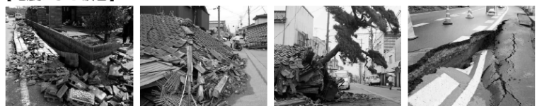
【地震による被害】
