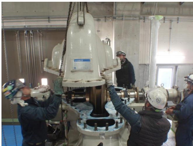
分解点検中の野代導水ポンプ所ポンプ設備
