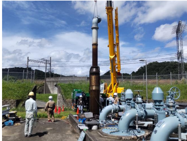
分解点検中の高野浄水場取水ポンプ設備
