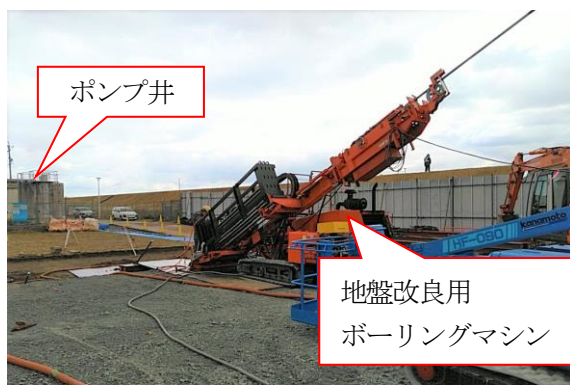
木造取水所取水ポンプ井耐震補強(地盤改良工)の施工状況
