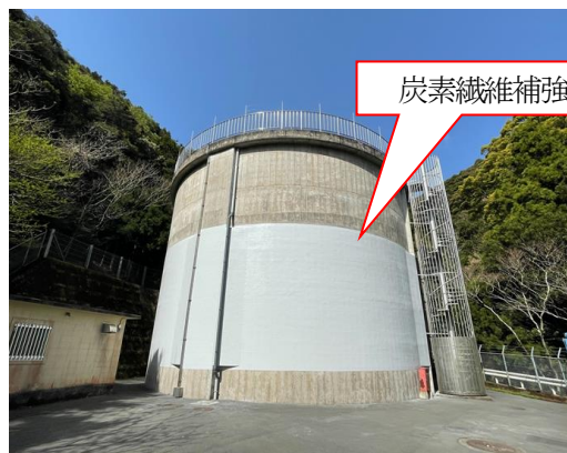
耐震化が完了した鍛冶屋調整池
