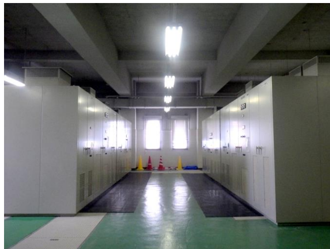
更新が完了した鈴鹿導水ポンプ所ポンプ制御設備
