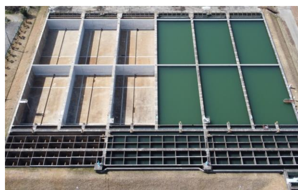
耐震化が完了した伊坂浄水場
