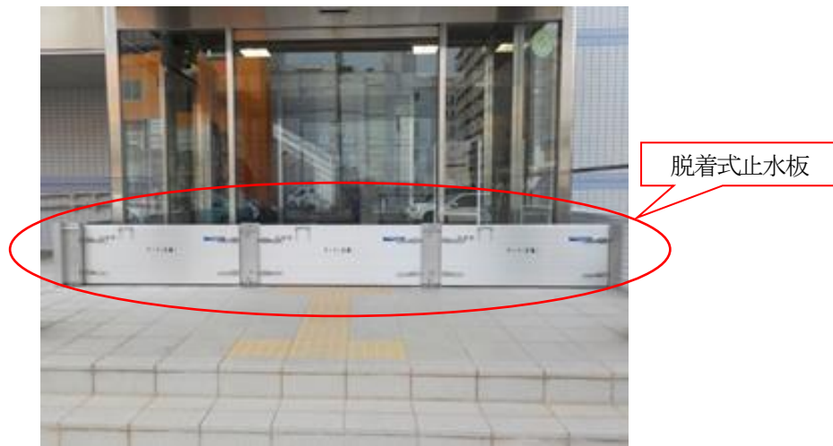
浸水対策が完了した北勢水道事務所管理本館
