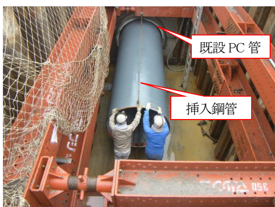
P I P工法による既設管更生工事の施工状況
