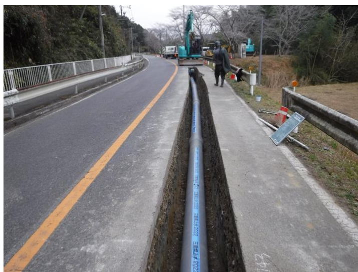
耐震管（内径300mm）布設工事の施工状況
