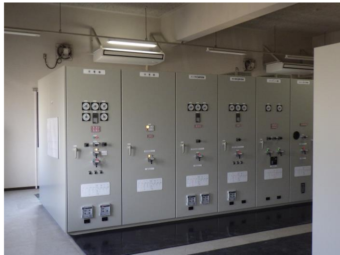
更新が完了した山村浄水場受変電設備
