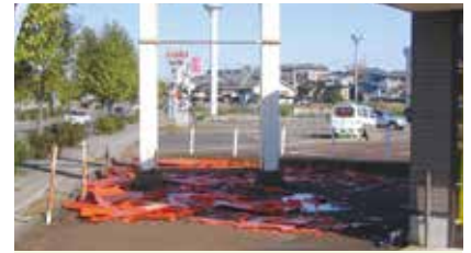
落下した屋外看板
