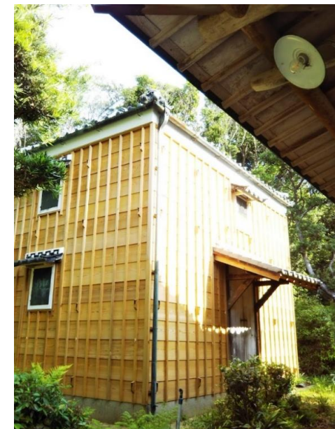
蔵の新しい外壁
