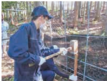
本伏せ土台作り作業
