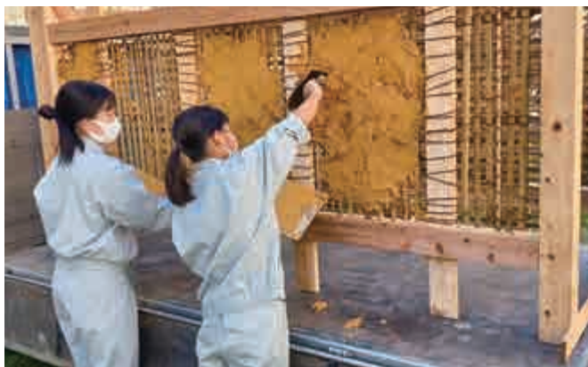
土壁塗りの様子
