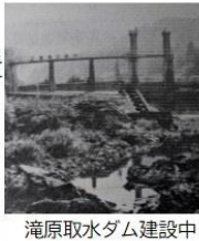
滝原取水ダム建設中
