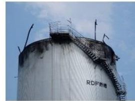
三重ごみ固形燃料 RDF 貯蔵槽
