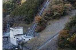
大和谷発電所
