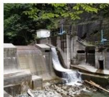
菅谷川取水口
