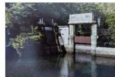
不動谷取水口
