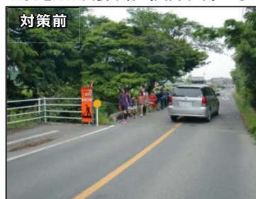
主要地方道宮妻峡線(四日市市) 歩道整備
