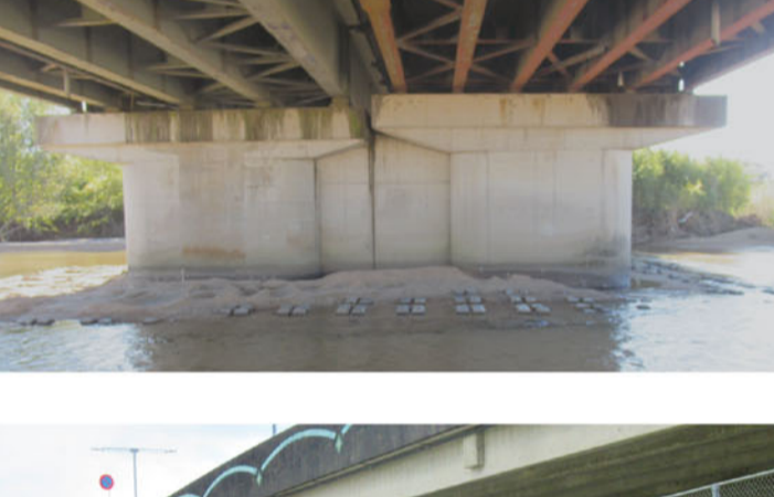
一般県道三行庄野線 汲川原橋(耐震補強)
