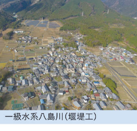
一級水系八島川(堰堤工)
