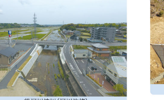
一級河川椋川(河川改修)
