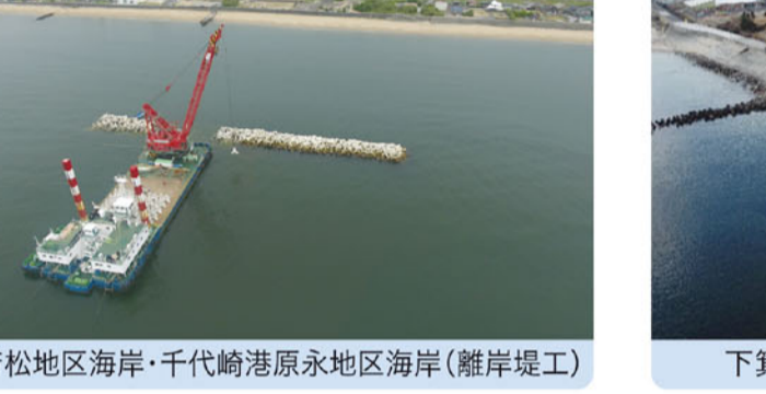
南若松地区海岸・千代崎港原永地区海岸(離岸堤工)
