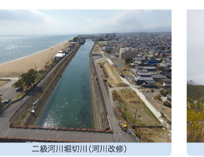
二級河川堀切川(河川改修)
