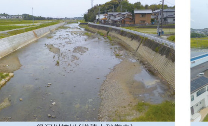
一級河川椋川(堆積土砂撤去)
