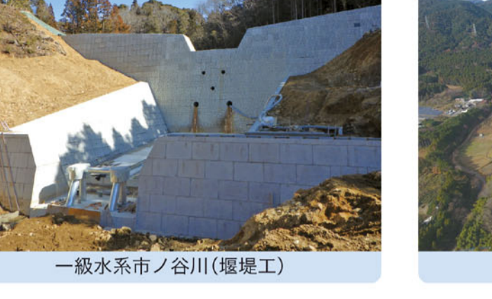
一級水系市ノ谷川(堰堤工)
