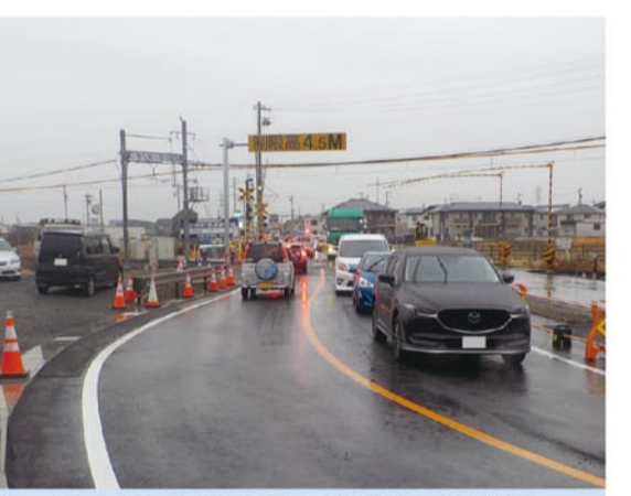
主要地方道四日市鈴鹿環状線(歩道整備)
