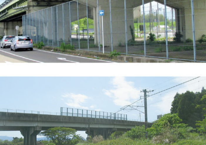
主要地方道神戸長沢線 JR跨線橋(耐震補強)
