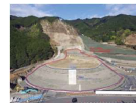
▲作業現場の様子
