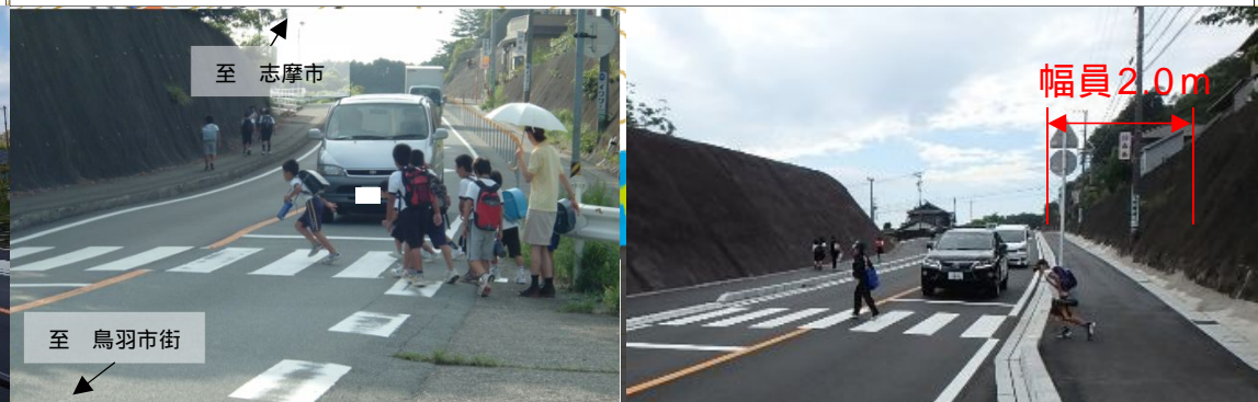
（対策前） 写真 （終点側） （対策後）
