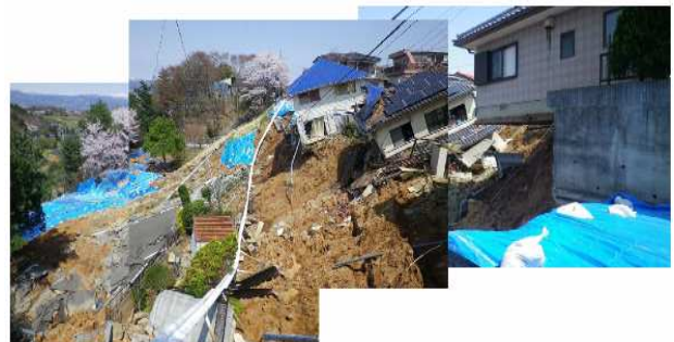
(d)液状化による側方流動
