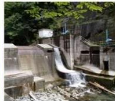
菅谷川取水口
