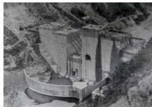
宮川ダム建設中
