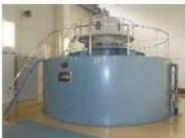
宮川第一発電所
