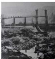
滝原取水ダム建設中
