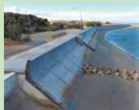
Biện pháp ứng phó với sóng thần và thủy triều bằng cách cải tạo đê, v.v...
