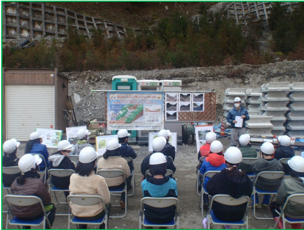
青川国補通常砂防（1号堰堤前庭保護工）工事現場の見学
