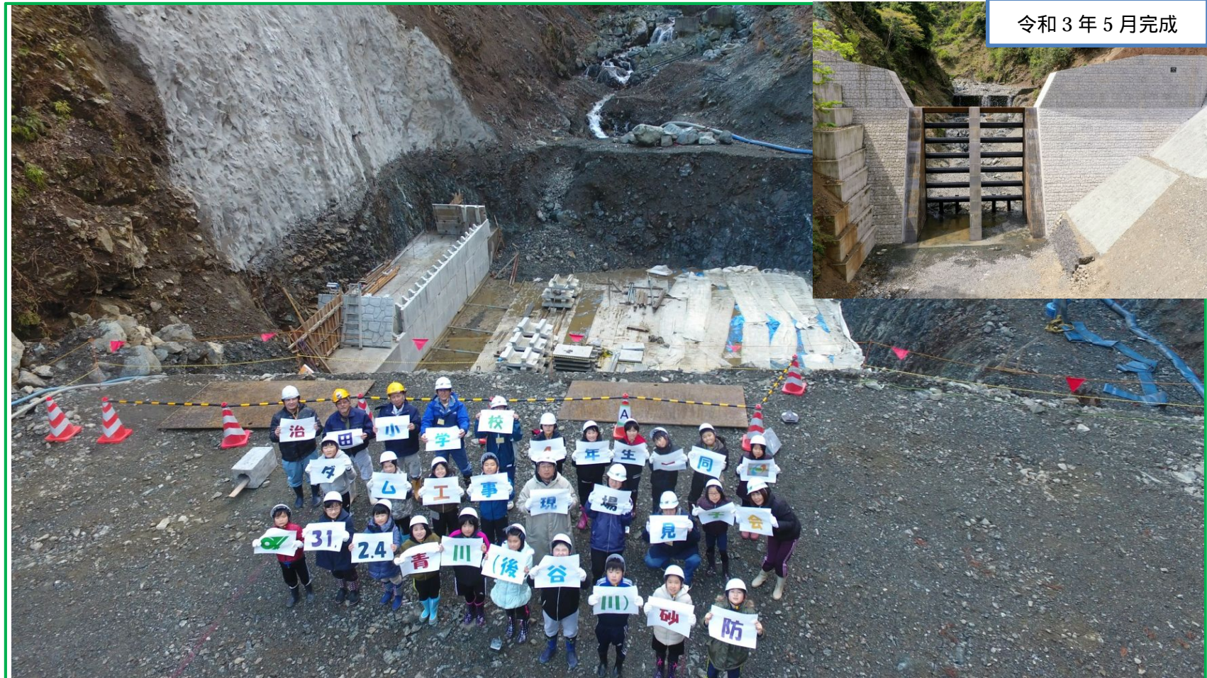
建設中（平成31年2月4日当時）の青川（後谷川）砂防堰堤をバックにして記念撮影 【当時の小学4年の児童の皆さんの後ろにあるのが、約4年前に施工していた後谷川砂防堰堤です。】
