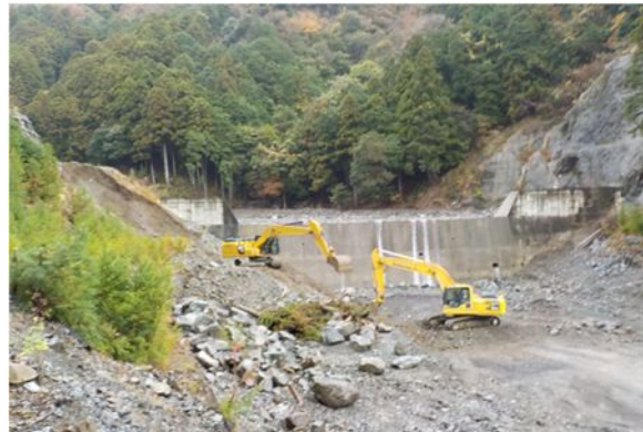
二級水系員弁川水系青川国補通常砂防(1号堰堤前庭保護工)工事
