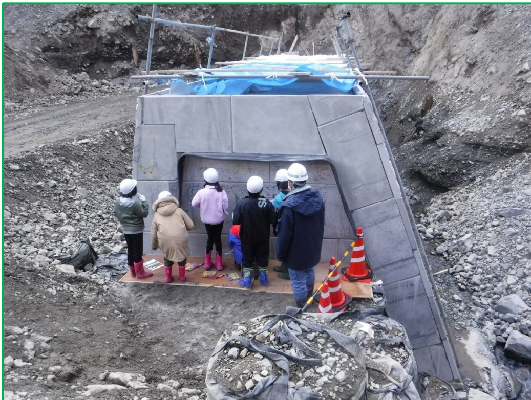
工事中の砂防堰堤に寄せ書きをしていただきました。
