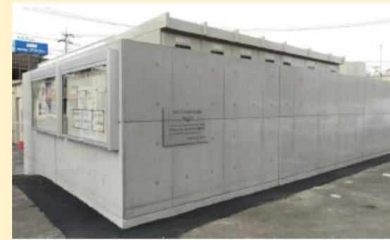
受電設備の囲い塀の設置※2
