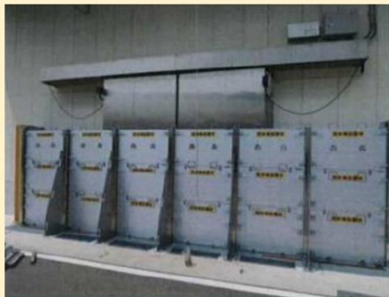
止水板の設置※4
