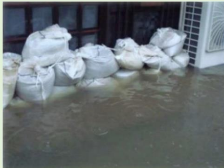
土のうの設置※1
