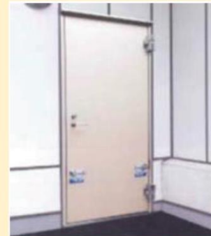
防水扉の設置※2
