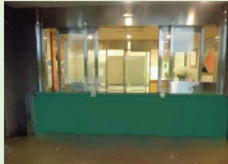
止水シートの設置※2
