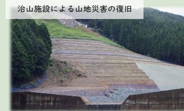
治山施設による山地災害の復旧
