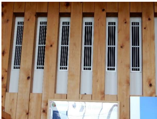
熊野古道センター換気設備修繕
