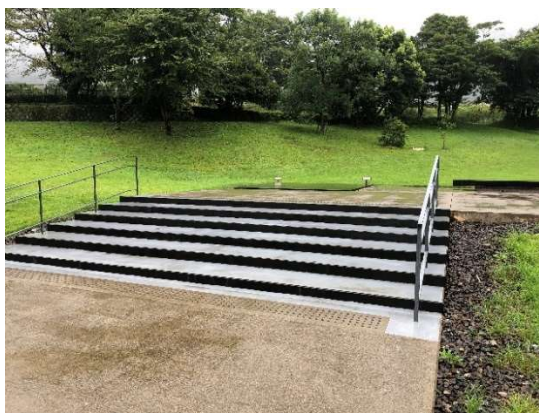
熊野古道センター中央階段修繕
