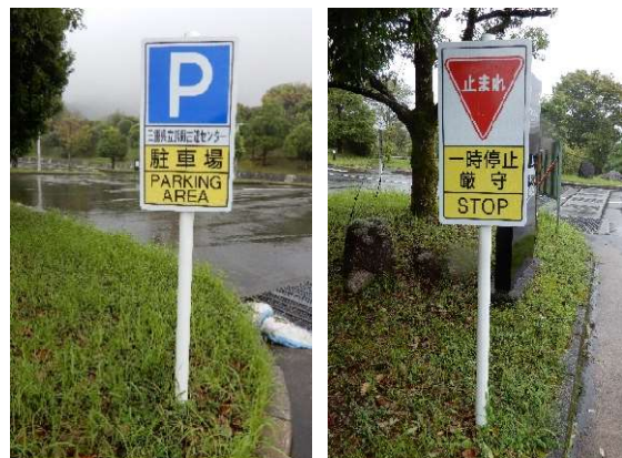
熊野古道センター駐車場内標識交換
