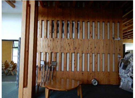
熊野古道センター空調機器修繕
