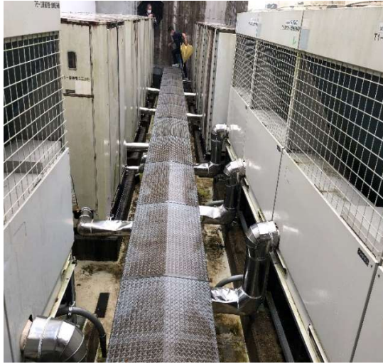
熊野古道センター空調機器修繕
