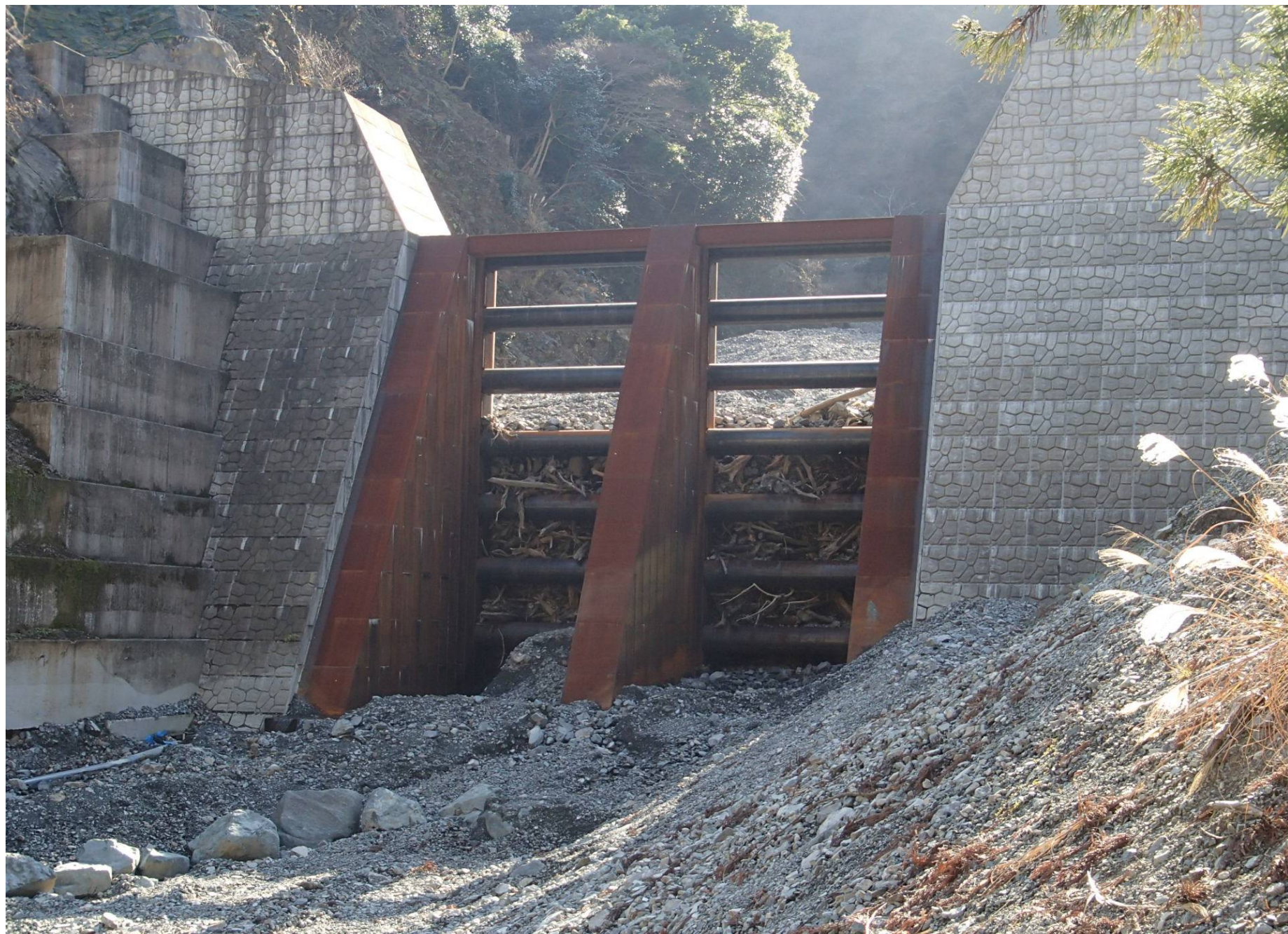
二級水系員弁川水系青川（後谷川）砂防堰堤（令和3年5月完成）
