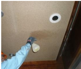
(飛散抑制剤にて湿潤化)
