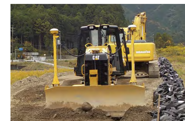
ICT建機施工状況
