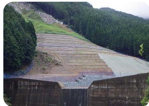
治山施設の整備
