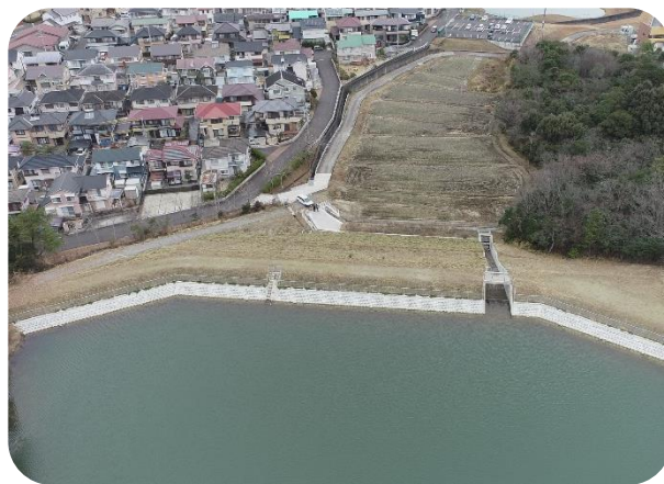
農業用ため池の整備
