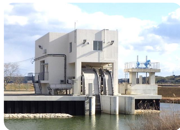
排水機場の整備
