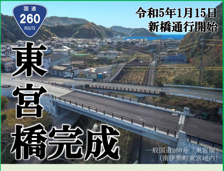
一般国道260号の東宮橋(南伊勢町東宮 地内)の架け替え工事が完成し、 令和5年1月15日(日)午後1時から新しい橋が通行できるようになります。 東宮橋は、1960年の架橋後62年が経過し老朽化し、耐震性能も不足していた ことから、国道260号東宮河内 I 期工区(1.8km)の一部として平成26年から 工事を進めてきました。引き続き、残る東宮橋の西側(約1.6km)の道路改良工事 を進めていきます。
