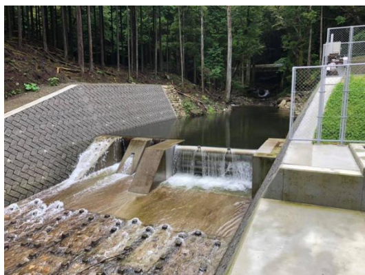
＜馬野川小水力発電施設（取水口）＞
