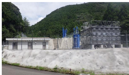
浄水施設全景
