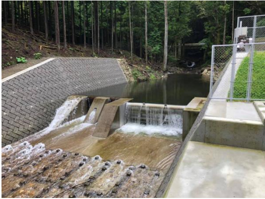
＜馬野川小水力発電施設（取水口）＞
