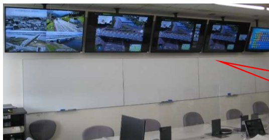
大型モニター4面新設
