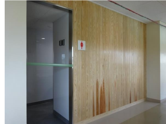
四日市高等学校 (トイレ改修) (教育委員会)
