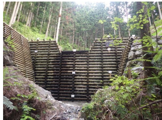
治山ダム工（校倉式）
