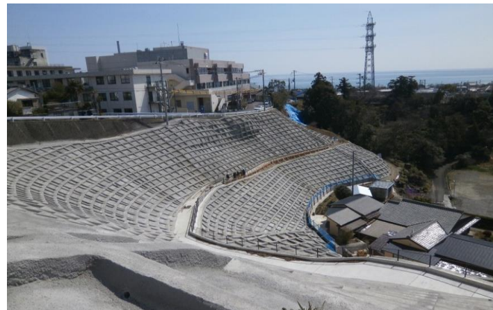
阿田和地区急傾斜地崩壊対策事業
