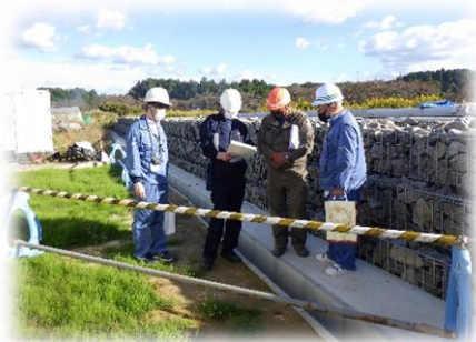
労働基準監督署職員による点検状況（名張市内）
