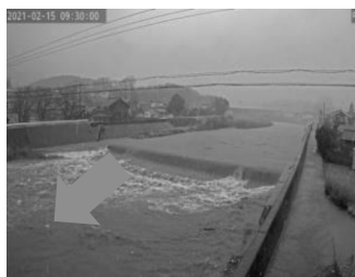
簡易型河川監視カメラ
