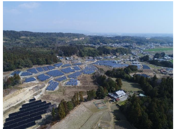
里山に設置された太陽光発電施設
