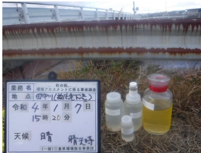
写真 2-1-29 供用後採水状況(田中川 1 : 下流) 令和 4 年 1 月 7 日
