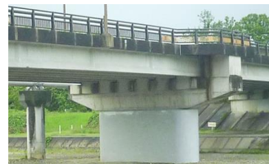
橋脚の補強 一般国道306号 菰野大橋（菰野町）
