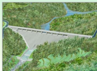
水害対策： 治水ダムの建設、河川の改修(堤防の改修、河道掘削等)、河川の堆積土砂撤去等
