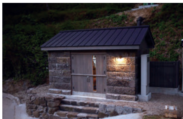
石積みみの発電所建屋
