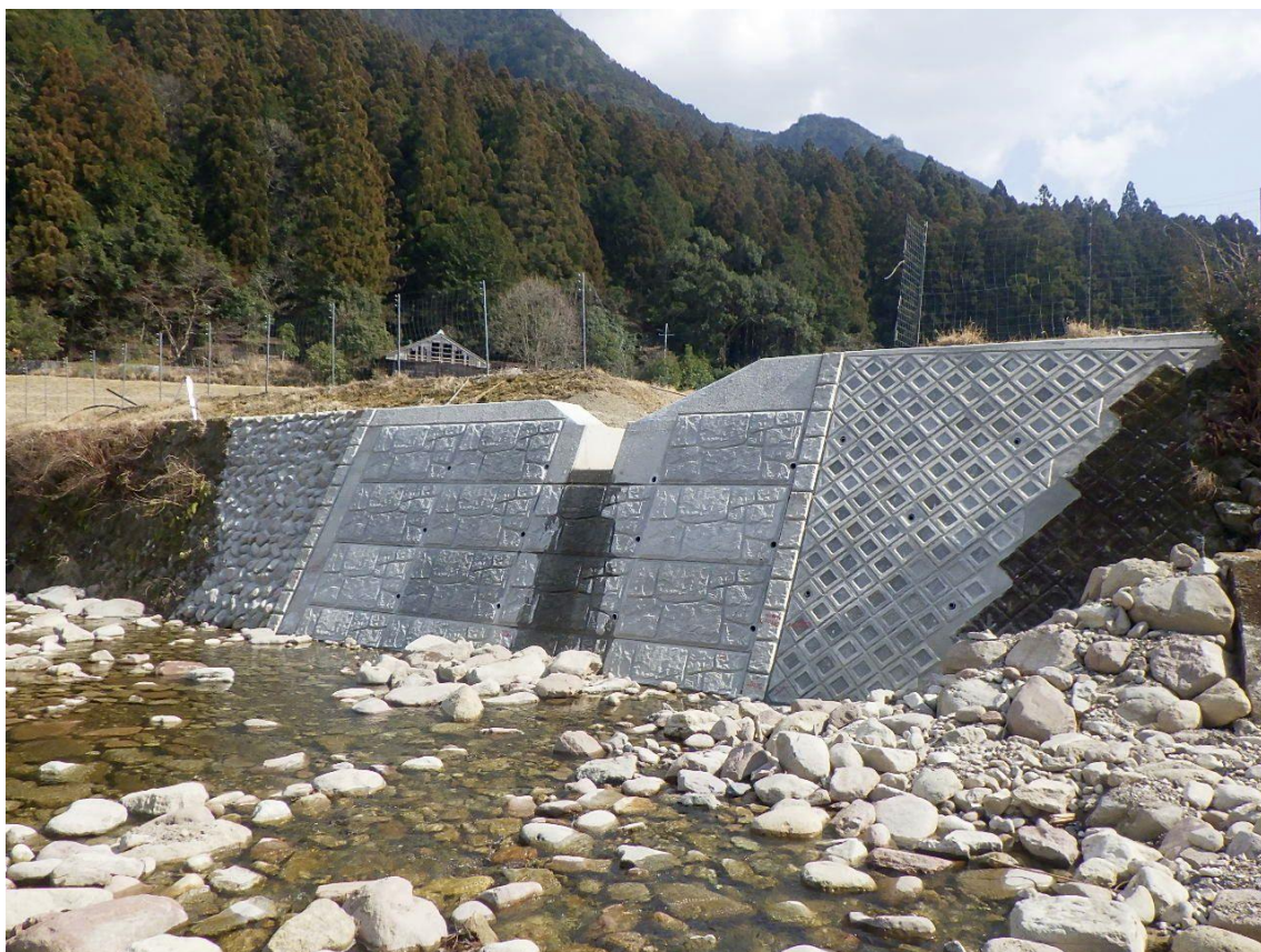
護岸工（大型ブロック積） A=49\text{m}^2
