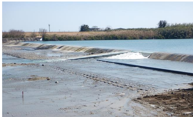
新屋敷取水堰(松阪市)
