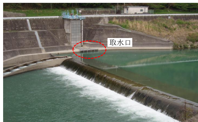
津留取水堰(多気町)
