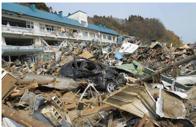
東日本大震災の被害
