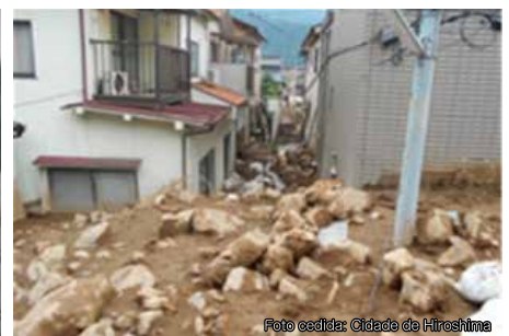
Avanço de terras e pedras
